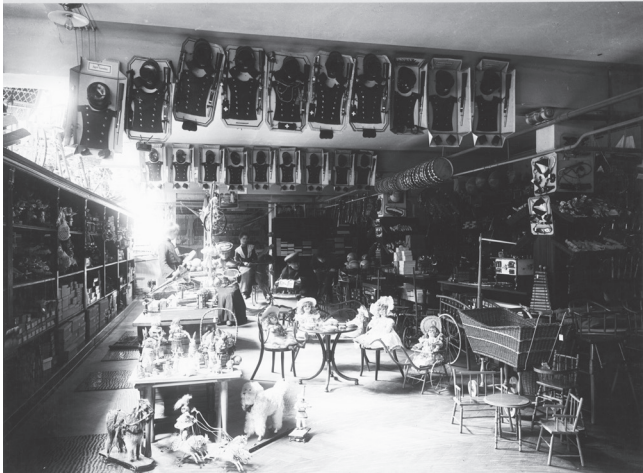
Spielwarenabteilung im Geschäftshaus Jelmolli, 1903, Johannes Meiner, Zürich. © Baugeschichtliches Archiv der Stadt Zürich
